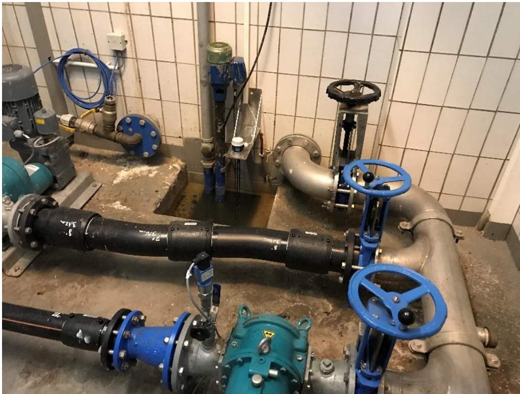
Abbildung 1-2: Rohschlamm pumpwerk Ansicht B
