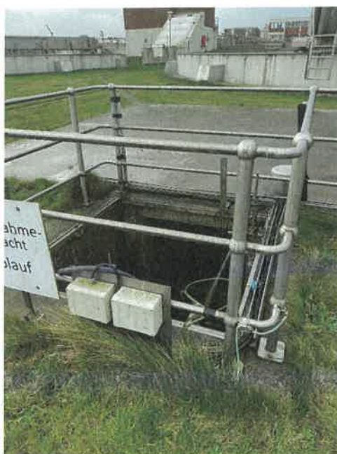
Abbildung 5: Probeschacht / Bypass für Filtrationspumpwerk
