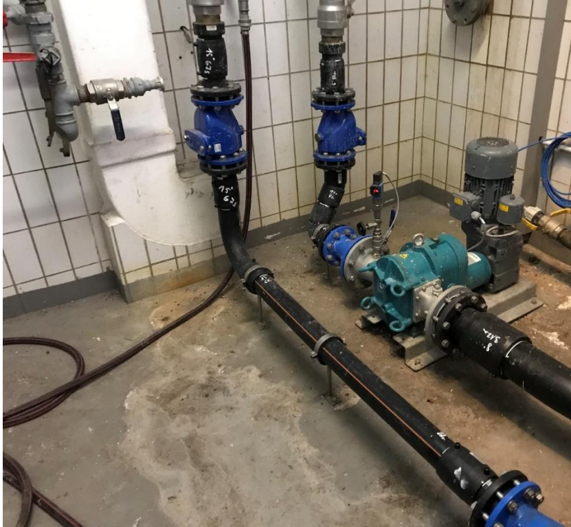
Abbildung 1-1: Rohschlammumpwerk Ansicht A
