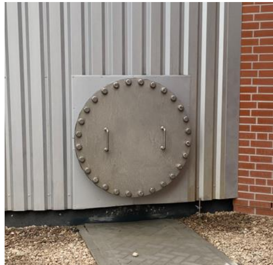
Abbildung 4: Beispiel eines Mannlochs bei der Fertigstellung
