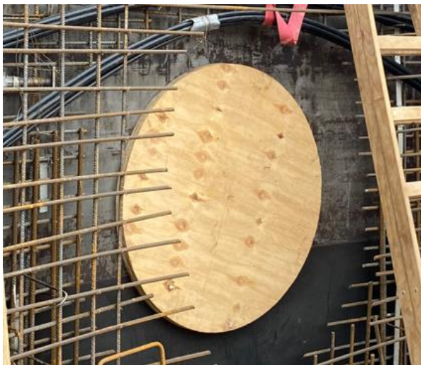
Abbildung 3: Beispiel eines Mannlochs in der Bauphase
